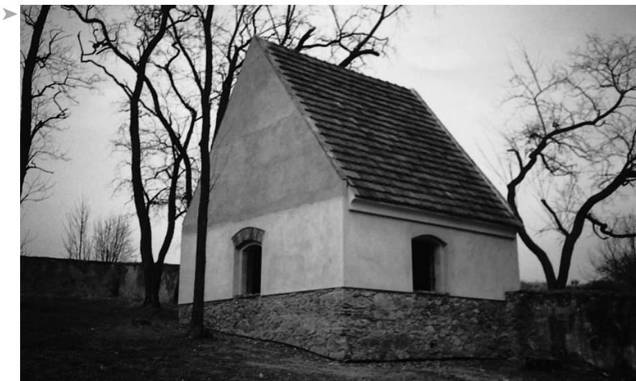
Nově zrekonstruovaná márnice v Prčicích.
