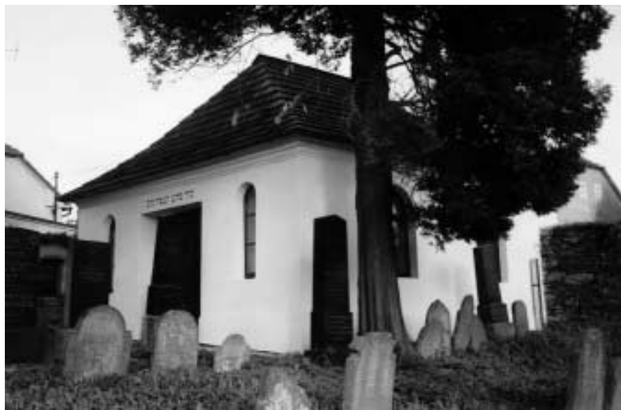
Rekonstruovaná márnice na pacovském hřbitově
