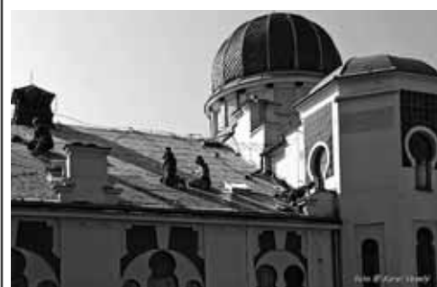
Pokrývači starou krytinu vyměnili za kvalitní přirodní břidlici
